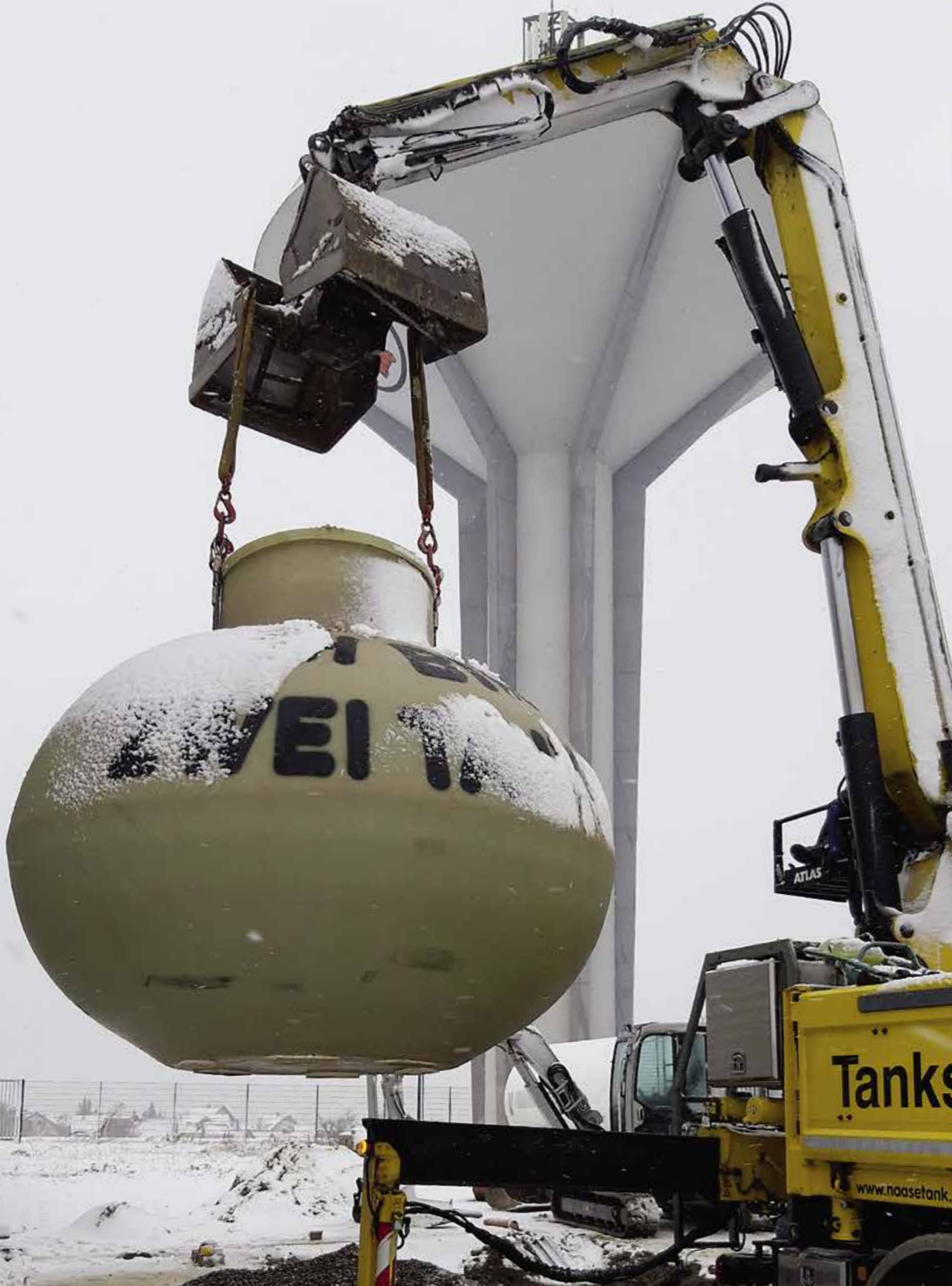
Installation eines Dieseltanks am Wasserwerk Niedernhall (Fassungsvermögen: 6 m 3 ).
