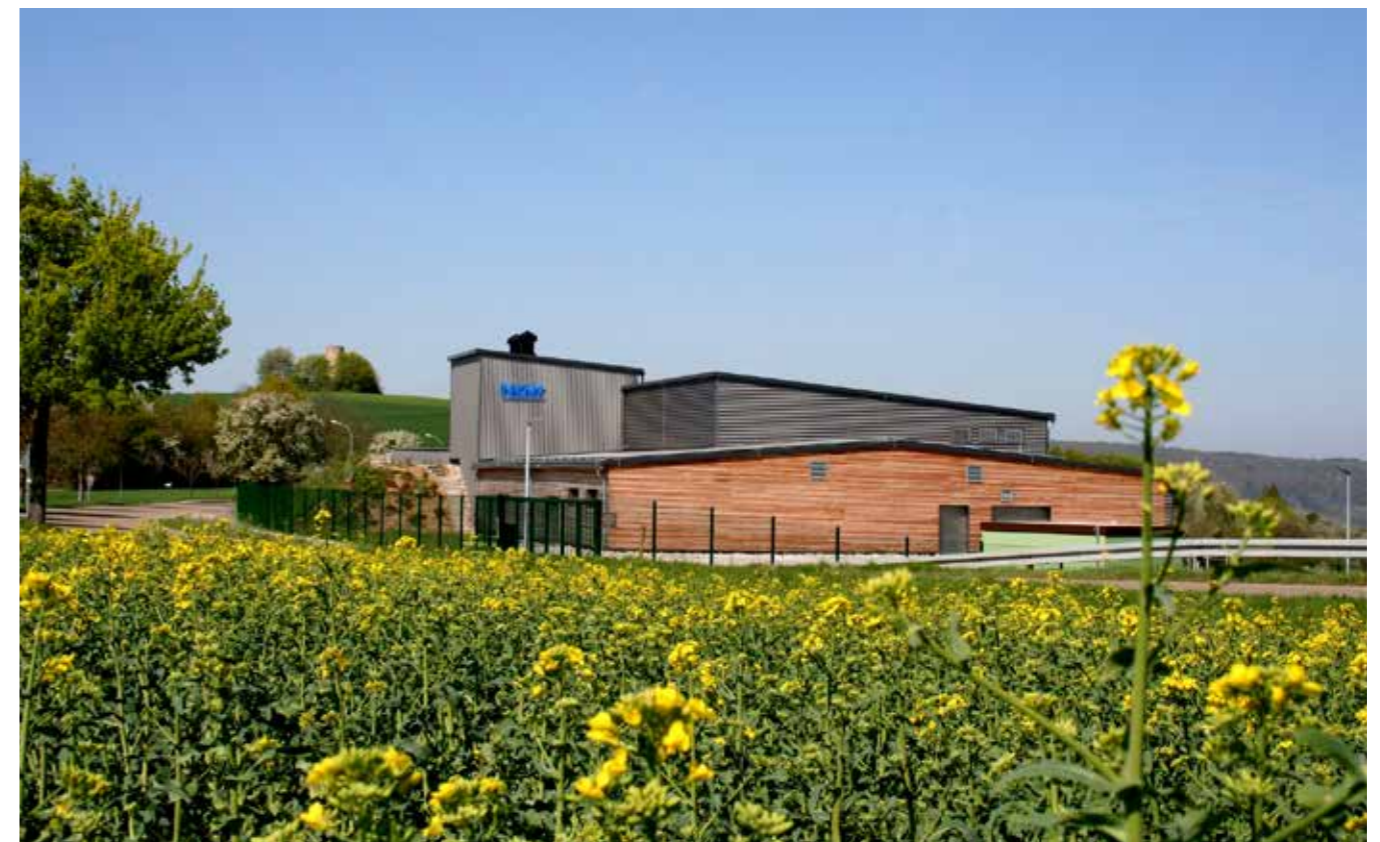
Wasserwerk Wart (Bad Mergentheim)
