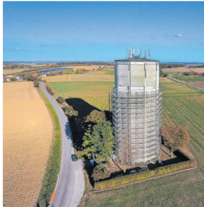
Der Wasserturm bekommt eine neue Außenfassade. Foto: Ufuk Arslan
