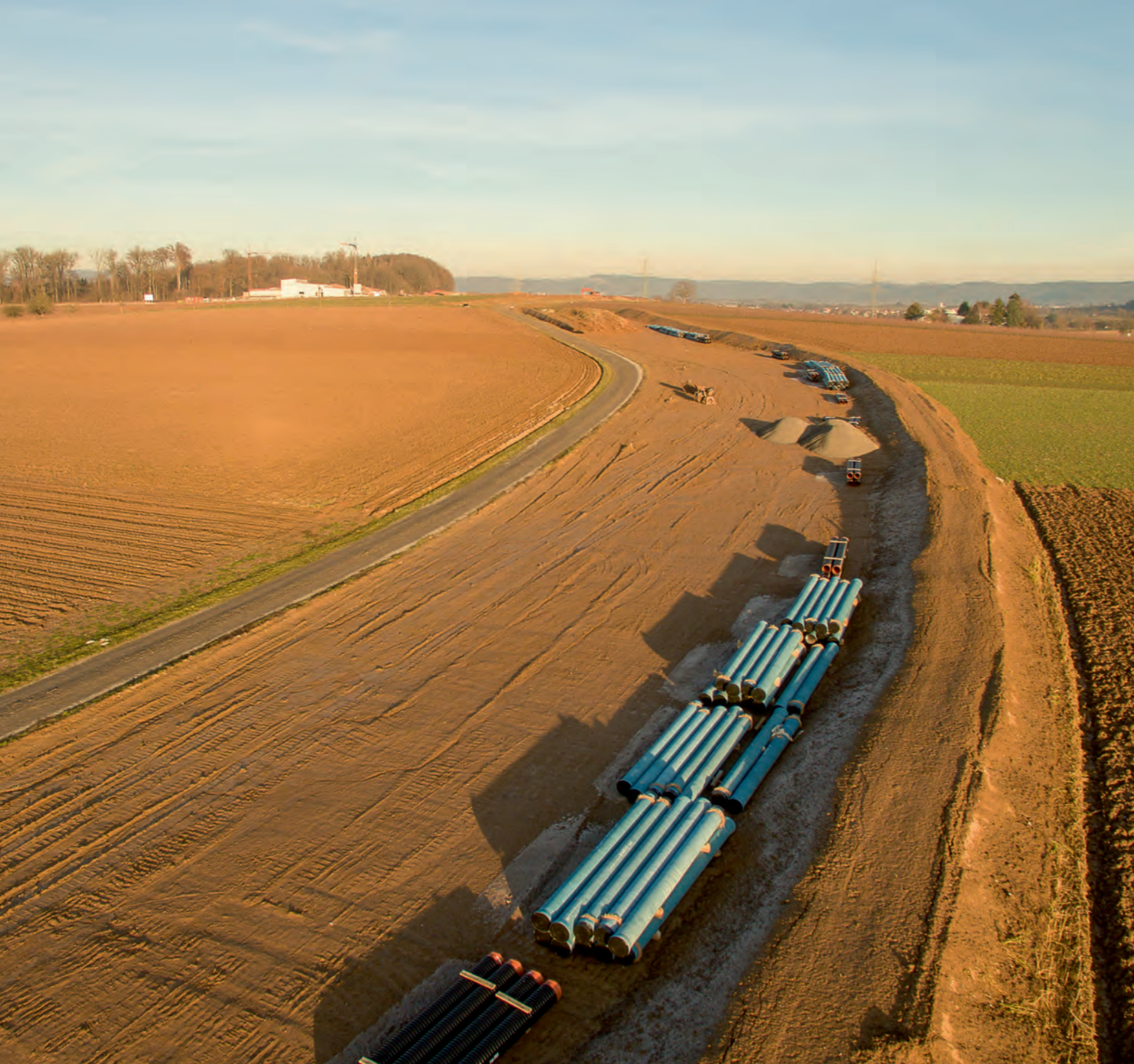
Leitungsbau im nördlichen Rems-Murr-Kreis zwischen Erbstetten und Leutenbach (im Hintergrund das im Bau befindliche Wasserwerk Murrthal)
