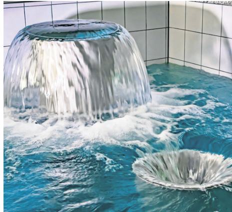
Ein Blick in die Mischwasserkammer Foto: NOW
