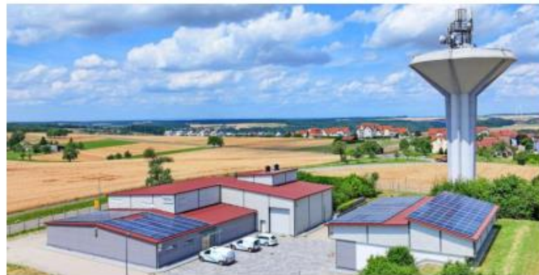
Das Wasserwerk Niedernhall versorgt Gemeinden im Kocher- und Jagsttal mit Trinkwasser. Das Foto entstand vor der jüngsten Erweiterung.
