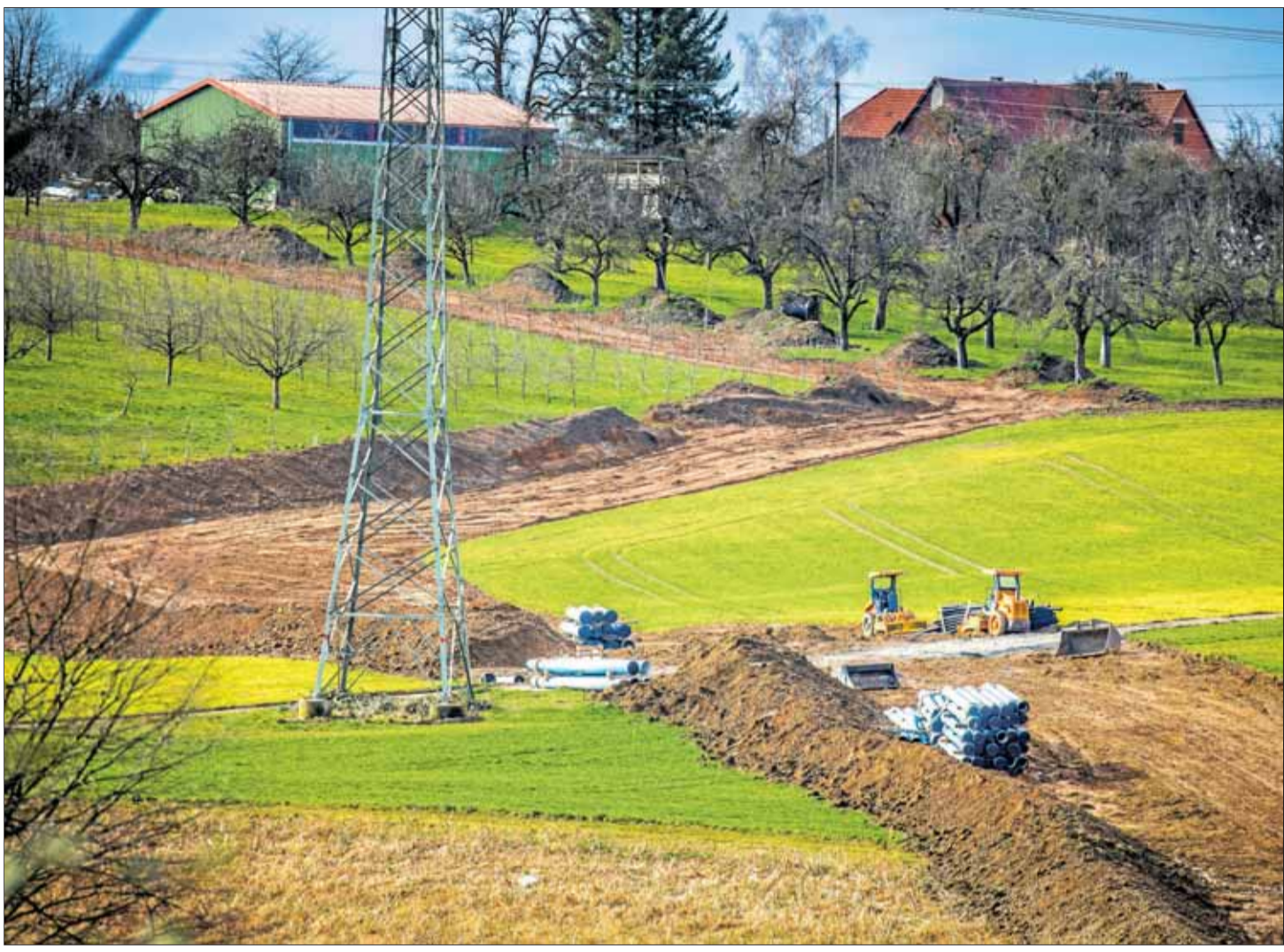
Zum neuen Wasserwerk Murr in Erbstetten hin werden aus vielen Richtungen Wasserleitungen verlegt wie hier bei Backnang-Schöntal. Foto: A. Becher
