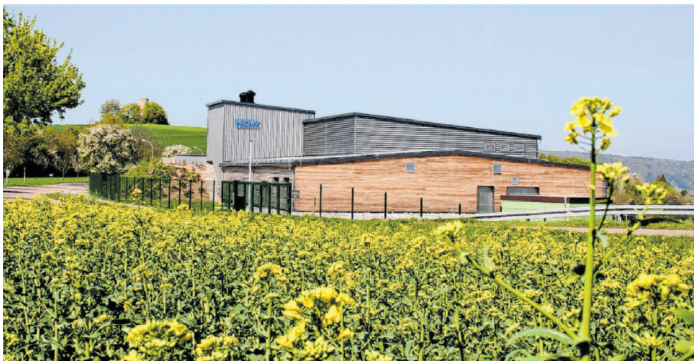
Das Wasserwerk Wart, das Bad Mergentheim und Igersheim versorgt, ist jetzt auch offiziell ans Netz gegangen.
